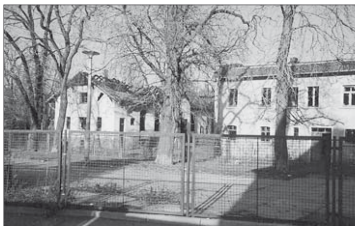
Gosenschänke (rechts) und Gartengebäude mit ausgebranntem Dachstuhl im November 1998
