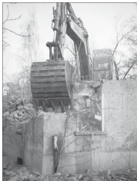
Der Bagger leistet ganze Arbeit – das Ende der Gosenschänke ist in Sicht, 10. Januar 2001
