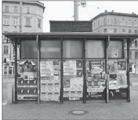
Das Toilettenhäuschen vor der Rekonstruktion
