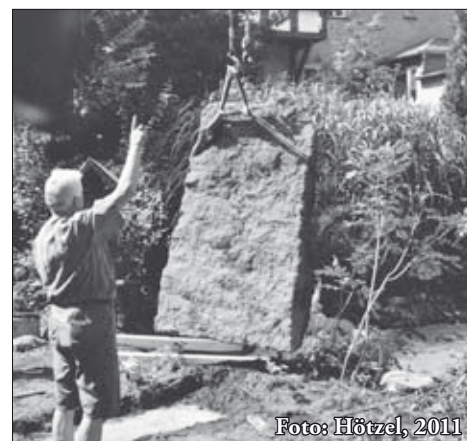
Mit einem Kran wird der Stein aufgerichtet und umgesetzt
