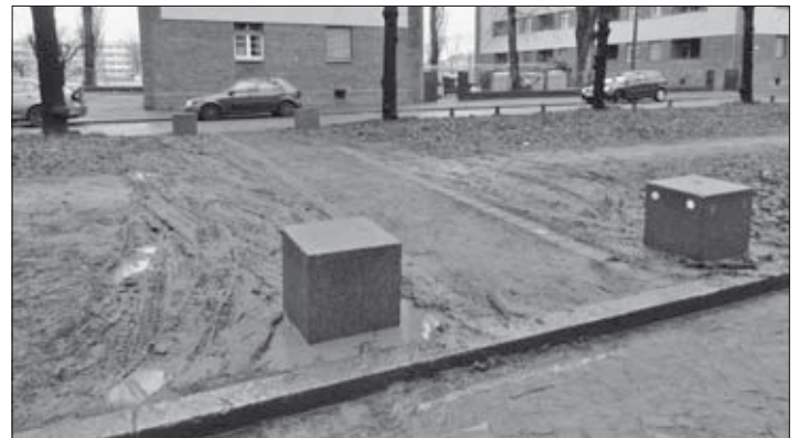
Steinquader verhindern nun diese erheblichen Schäden
