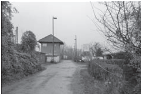
Bild 16: Anfang des Bahngeländes
