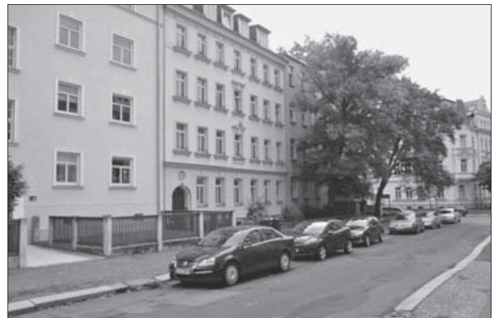
Die Bleichertstraße heute, mit dem Wohnhaus Nr. 12 (Mitte)
