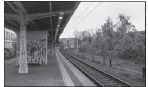
Bild 29: Bahnsteig Gohliser Bahnhof heute
