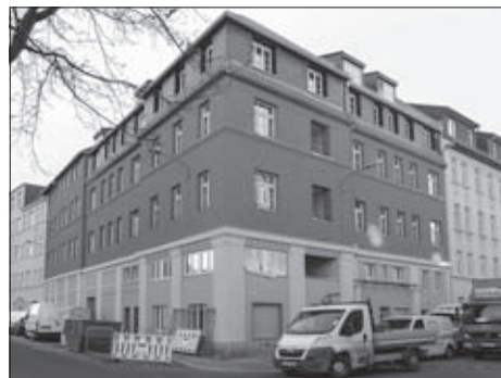
Bild 32: Fast abgeschlossene Sanierung vom Kino zum Wohnhaus, 2015
