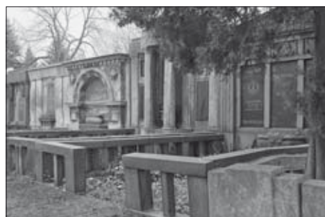
Ehrenreihe an der zum Nordfriedhof angrenzenden Mauer
