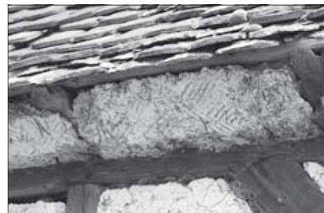
Ritzzeichnung an der Dachkehle
