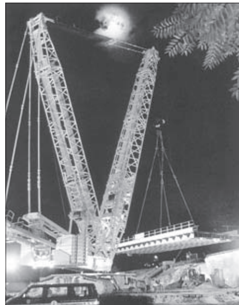
Dieser Raupendrehkran transportierte in der Nacht vom 11. zum 12. Oktober den nördlichen Teil der Eisenbahnbrücke über die Delitzscher Straße vom Montageplatz südlich der Petzcher Straße
