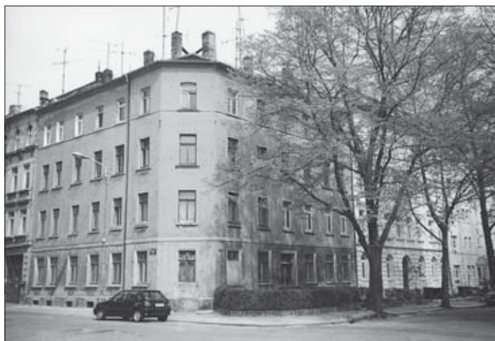
Die Wilhelminenstraße 29/Ecke Haferkornstraße am 2. Mai 1997, vor der Sanierung
