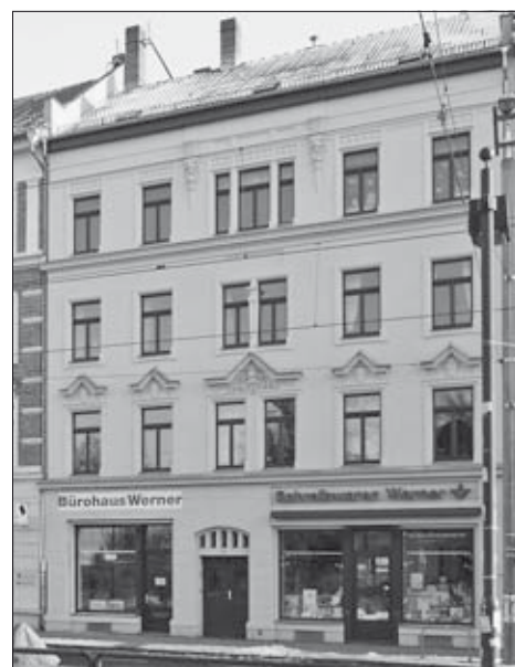
Die gestaltete Fassade Delitzscher Str. 72b
