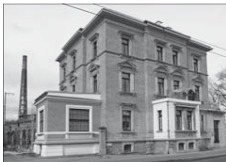
Gebäude Delitzscher Straße 15, März 2017
