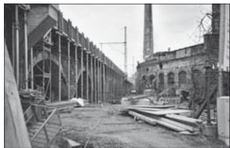
Blick von der Delitzscher Straße auf Viadukt und Fabrikanlagen, am 10.10.2003
