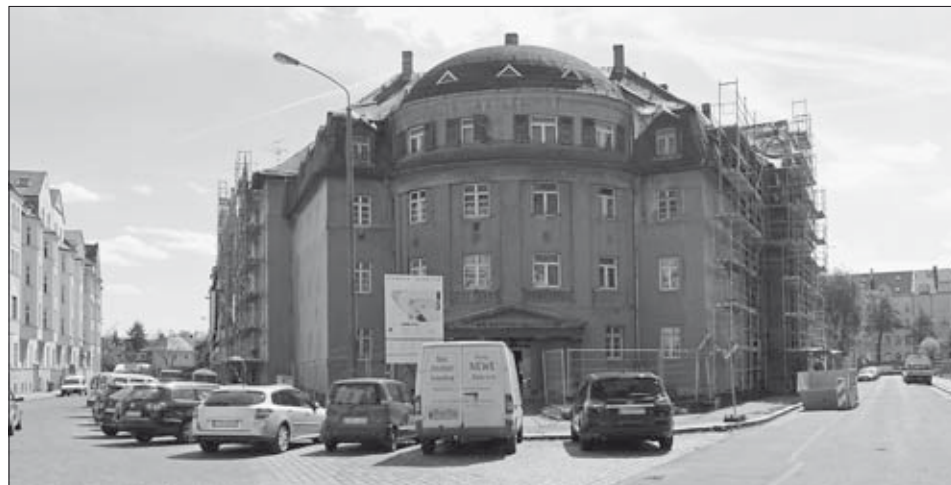
Baubeginn am „Riemann Quartier“, links die Kroker-, rechts die Renkwitzstraße Foto: VLW eG
