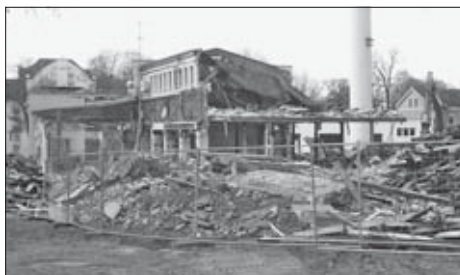
Stand des Abrisses am 20. April 2017
