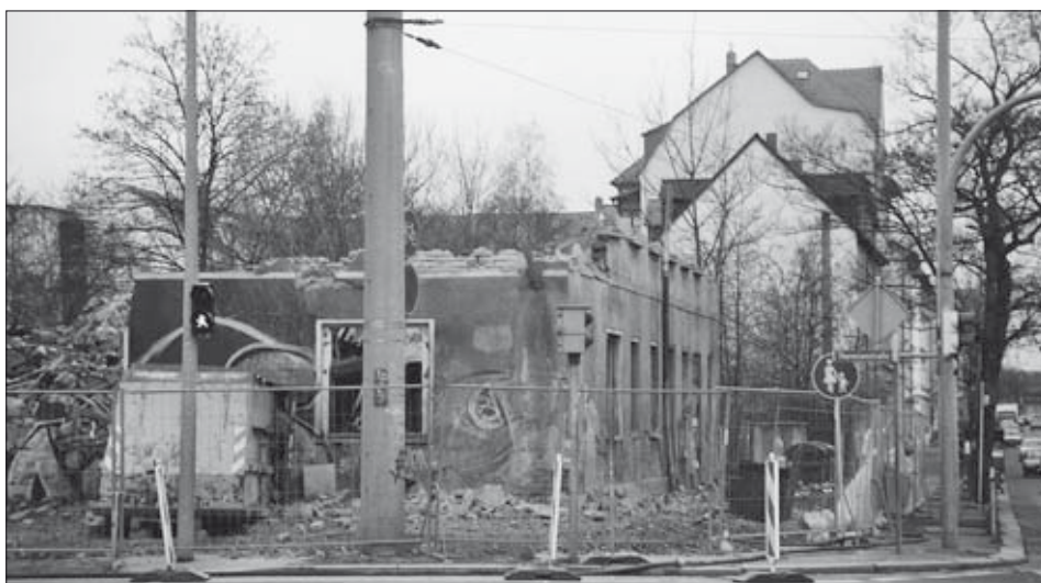
Abbruch der Wohnbebauung Wittenberger Straße 27 / Theresienstraße 33, am 18. Dezember 2006
