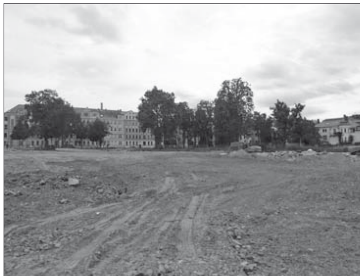
Der Abriss im Baugebiet für die Reinterassen ist bald beendet. Hier der Blick von der Gräfe Straße zur Delitzscher Straße, Juli 2017
