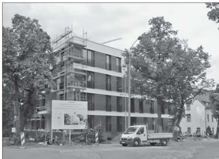
Die Villa am Eutritzscher Markt mit 12 Wohneinheiten ist fast fertiggestellt und soll mit einer Erinnerungsinstallation an die Eutritzscher Gosenschänke ausgestattet werden, Juli 2017
