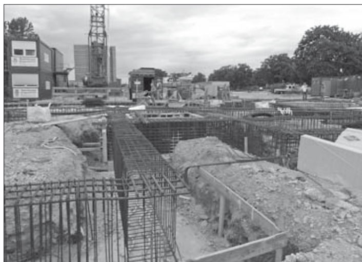
Auf dem Areal des entstehenden Altenheimes zwischen Görlitzer und Schönefelder Straße haben die Fundamentarbeiten begonnen, Juli 2017
