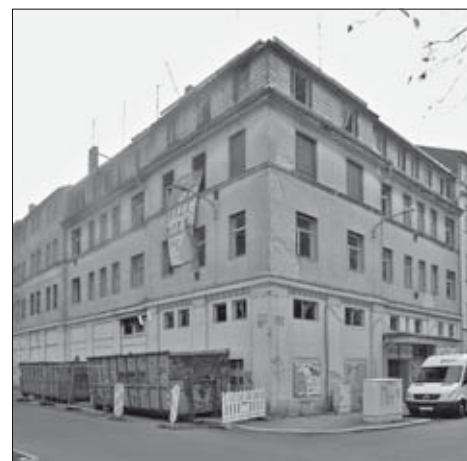
Das Eutritzscher Kino wird umgebaut, 2013
