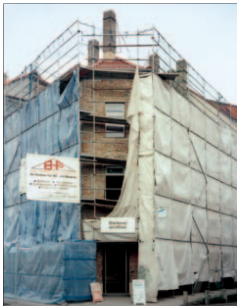
Das eingerüstete Eckhaus Delitzscher Straße 46/Ecke Schiebestr., am 13. Mai 1997 – Verkauf unter schwierigen Bedingungen
