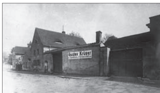
Das Fuhrgeschäft Gustav Krüger, Büнауstraße 3, nach 1920 Quelle: Privatarhiv Grundmann
