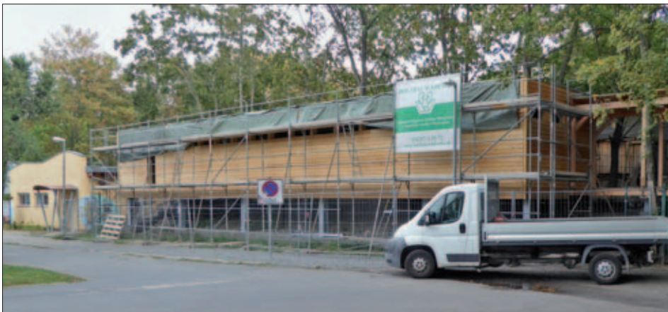
Das Mehrzweckgebäude im Bau, September 2019
