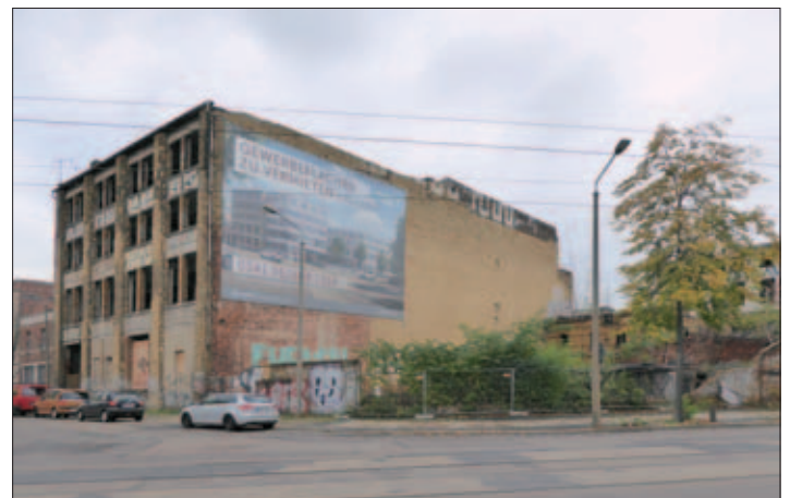
„PetschWORK“-Areal an der Zerbster / Ecke Wittenberger Straße, November 2019
