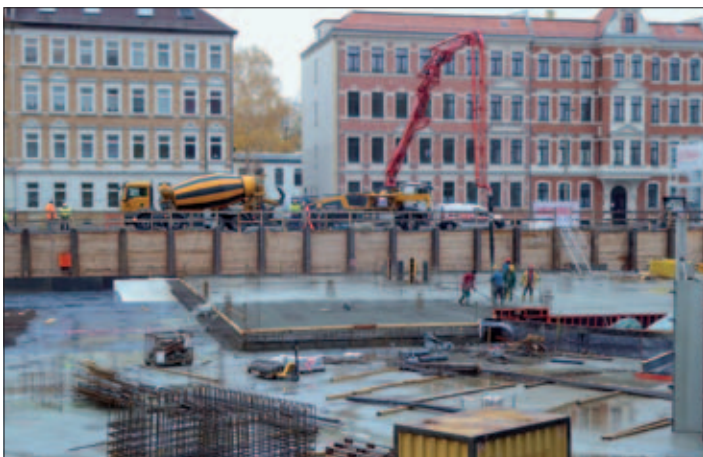
Baustelle „Magnolia“, Blick zur Hamburger Straße, November 2019
