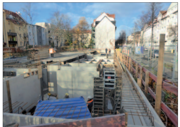
Die Baugrube an der Wittenberger Straße: es entsteht das erste Gebäude des Projektes „Magdalenenstraße Leipzig“, Foto vom 20.11.2020
