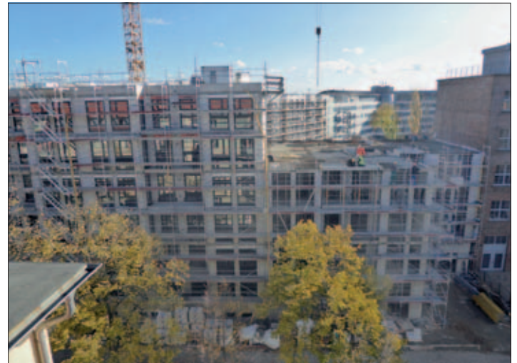
Blick auf den Wohnungsbaukomplex „Magnolia“ in der Hamburger und Dessauer Straße. Der Rohbau ist bald abgeschlossen, Fassaden werden isoliert und bis Ende 2021 soll das 187 Wohneinheiten umfassende Quartier fertig werden. Foto vom 16.11.2020
