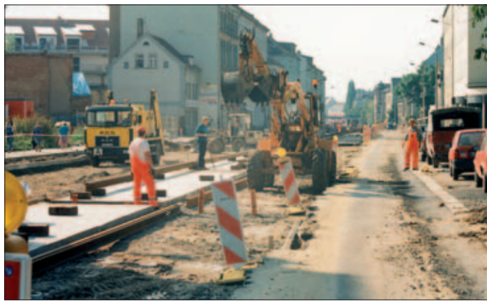
Umbau der Delitzscher Straße, 1995
