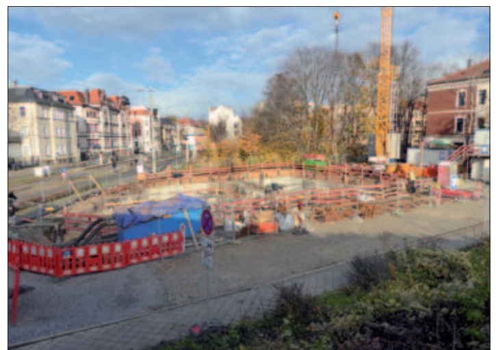
Blick auf das „Petzschers Eck“, wo nun bereits am Kellergeschoss montiert wird. Hier entstehen 16 Eigentumswohnungen und das Schachzentrum (siehe auch Beitrag auf Seite 16). Foto vom 20.11.2020
