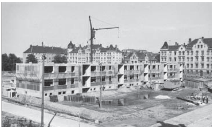
Baustelle Bernburger Straße 1967
