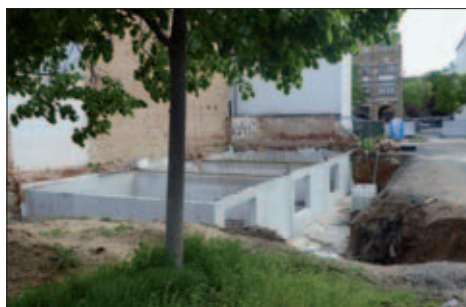
Bauzustand der Reihenhäuser, Mai 2021
