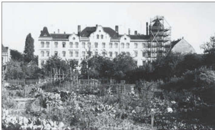
Die alte C-Anlage des Kleingartenvereins 1964
