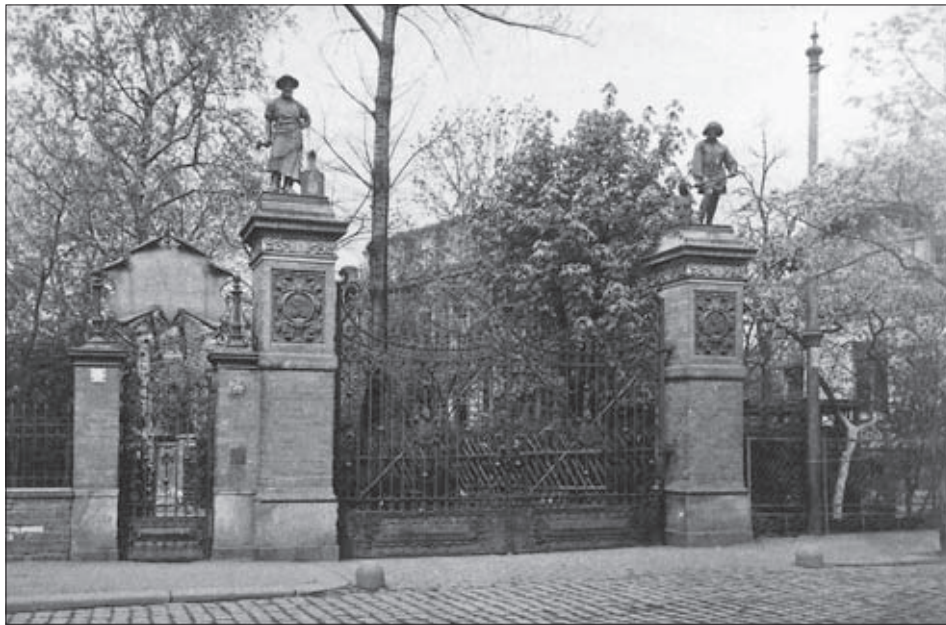
Tor/Zufahrt zum Firmengelände Franz Mosenthin, Delitzscher Straße 49, um 1900
