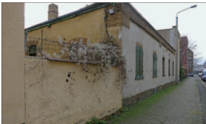
Hohmannstraße 8, ehemaliger Eingang von der Zerbster Straße, heute zugesetzt. Anschließend die früheren Fenster der Familie Heide (von links: Stube und Schlafzimmer), am 15. Dezember 2021.
