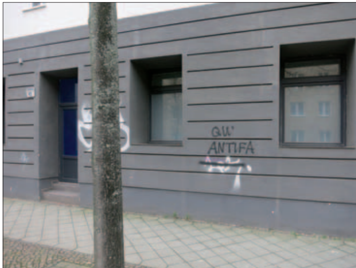
Die rechte Fensterfront der Delitzscher Straße 42, früher der Schokoladenladen, am 20. April 2023
