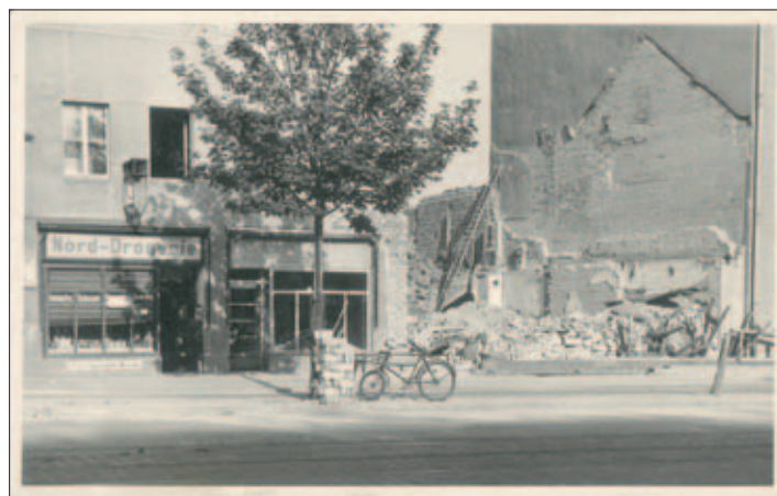
Abbruch im Bereich der „Nordstern-Drogerie“ (Nord-Drogerie) von Wilhelm Kühn, Delitzscher Straße 148
