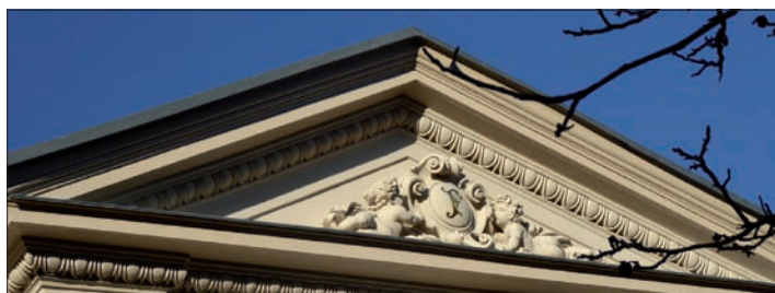
Detailansicht des straßenseitigen Giebels, Januar 2020
